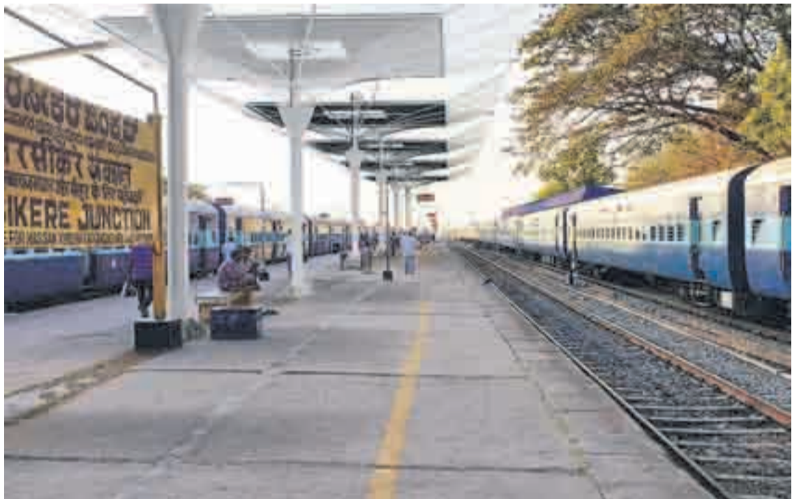
El sistema de captación de aguas fue apodado "Ulta Chaata" por su semejanza con un paraguas volteado por el viento.
