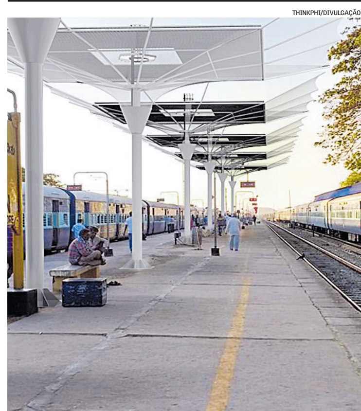
Equipamento da ThinkPhi instalado em ferroviária no Sudeste da Índia
