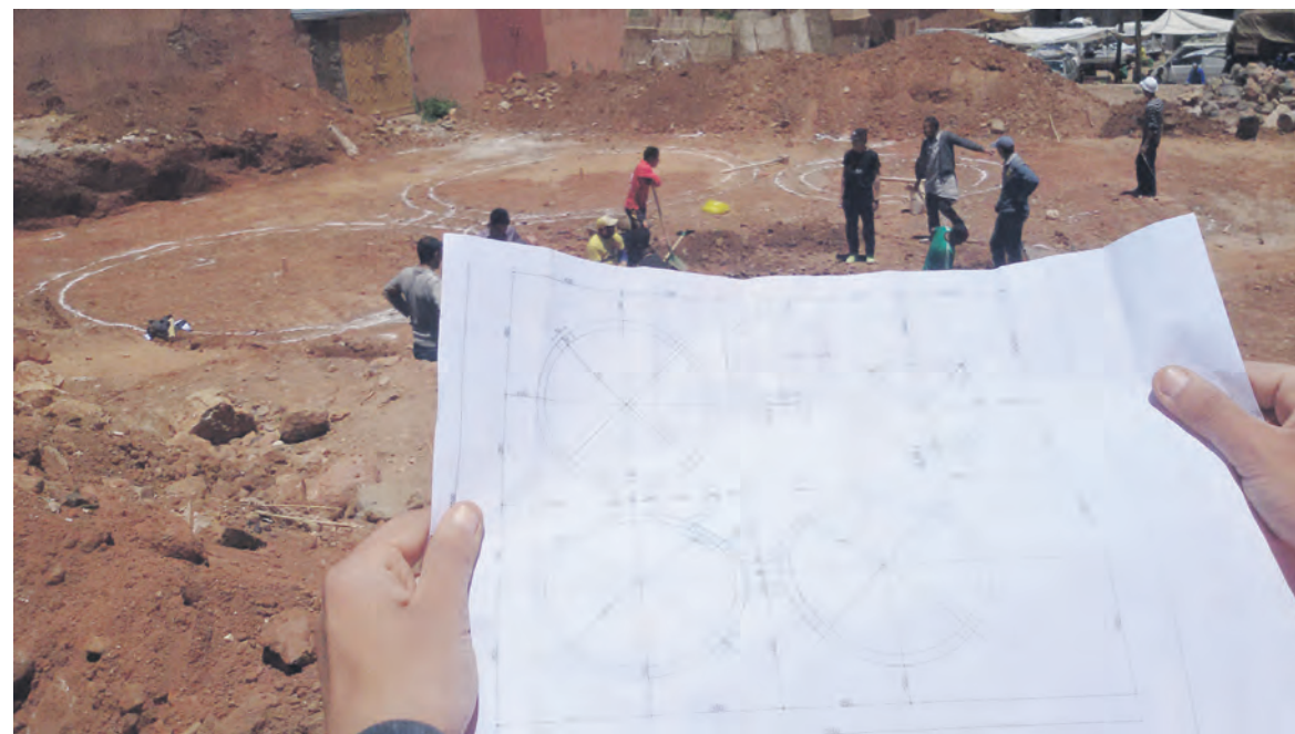
Un centre culturel de 250 m 2 au profit des élèves de la région d'Agouïm est actuellement en cours de réalisation. Il s'agissait là pour l'entreprise d'offrir aux enfants de cette région rurale, située entre Marrakech et Ouarzazate, un lieu où lire, créer et se cultiver (Source: Eco Dôme Maroc)
