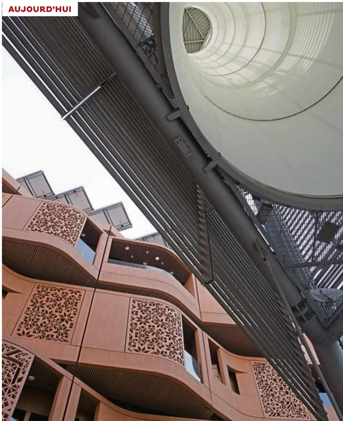
ABU DHABI. Une tour à vent, installée au centre de la ville, filtre l'air chaud qu'elle transforme en air frais, à l'aide d'un brumisateurs. Les fenêtres dotées de moucharabiehs réduisent la chaleur. Photo Duncan Chard/NYT-Redux-REA
