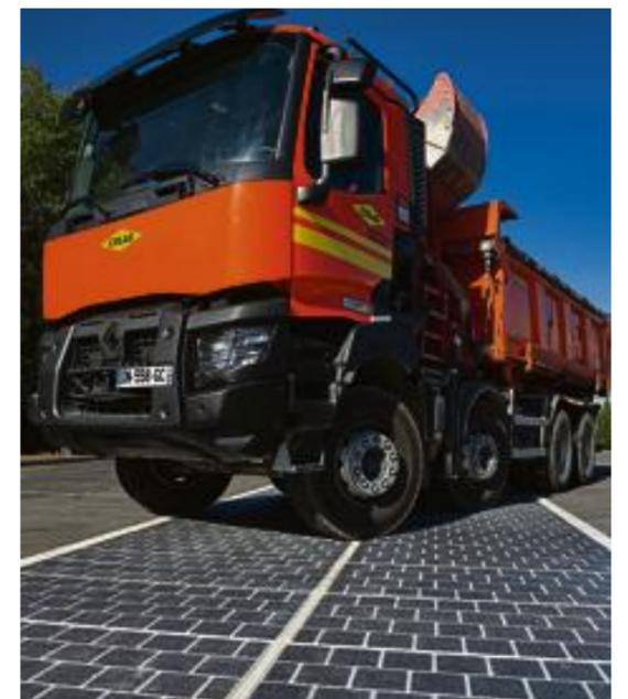
La route solaire se présente sous la forme de dalles dotées de cellules photovoltaïques et recouvertes de résine assez résistante pour supporter la circulation de poids lourds de 13 tonnes par essieu. Photo Joachim Bertrand / Colas
